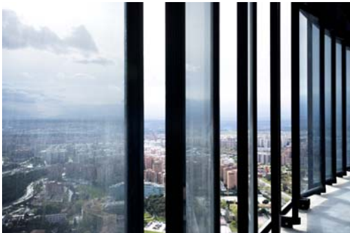
Doble ventana del edificio (cristalera exterior)
